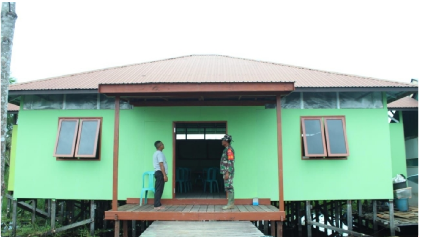
Rehab Balai BPD Rampung 100 Persen
