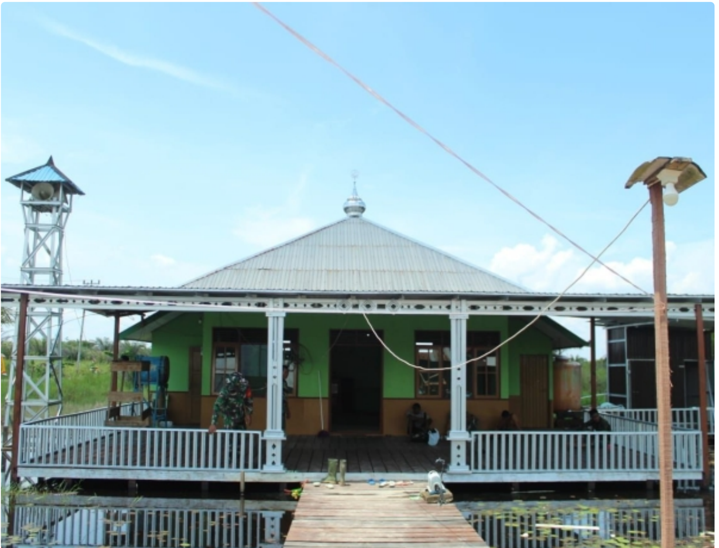
Sasaran fisik TMMMD 115 Rehab Masjid Jami' Al Hidayah Rampung 100 Persen
