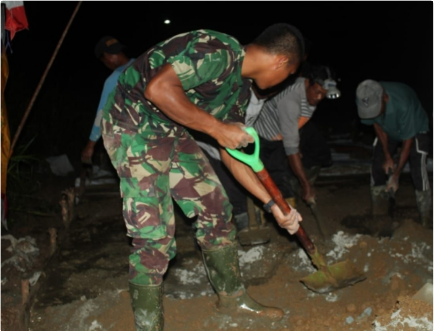
Satgas TMMMD 115 Kebut Cor Jalan Hingga Malam Hari
