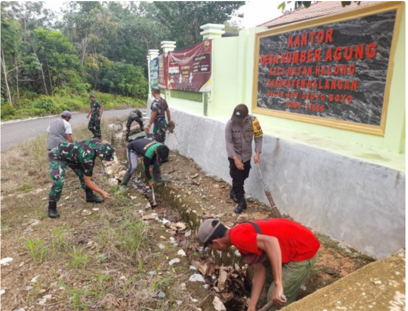
Tanggap Bencana, Koramil 1001-12/Halong Bersihkan Saluran Air
